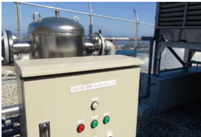
地熱バイナリー発電の CALFA SEP (大分県別府市)
