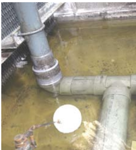
CALFA"SEP"「設置済み」冷却塔内部
